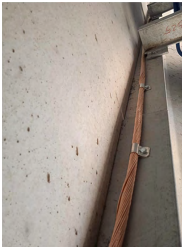
Imagen cable toma de tierra de la estructura de soportación.
