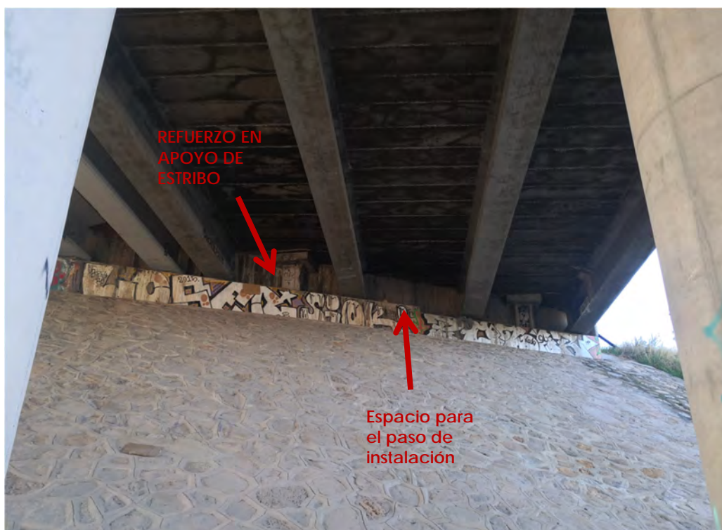
Paso de línea eléctrica en vanos 1 y 3.
