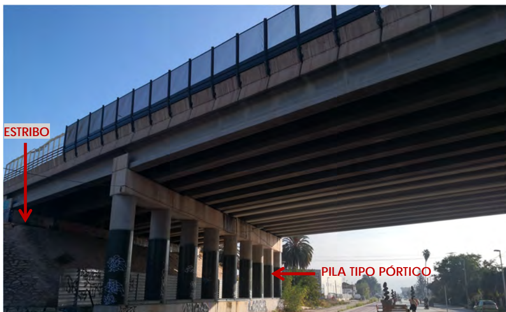
Imagen las pilas y de las vigas del tablero
