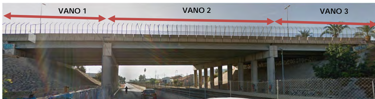
Vista lateral con identificación de vanos del puente.
