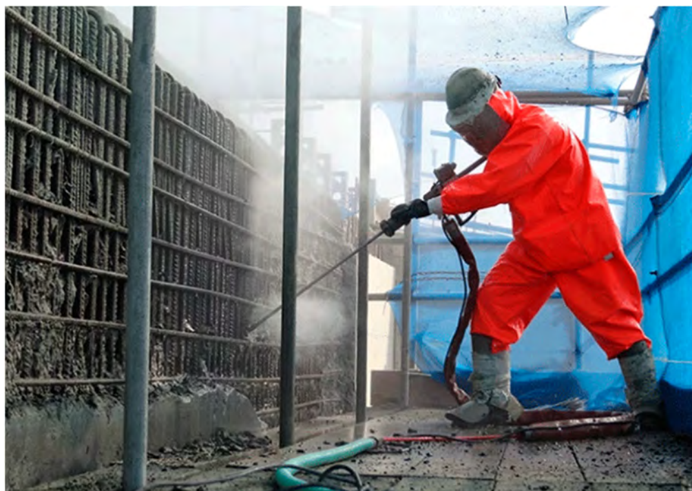
Imágenes de hidrodemoliciones con agua a presión.
